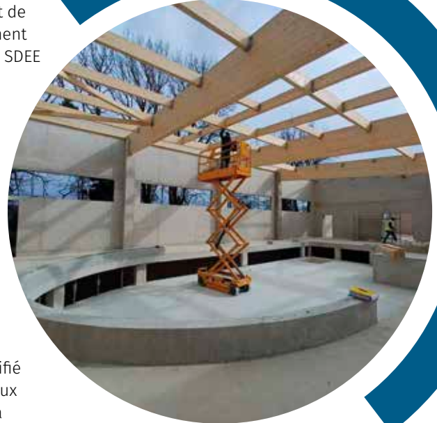
Chantier espace aquatique
