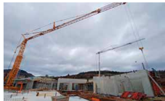
Chantier MAS Entraygues
